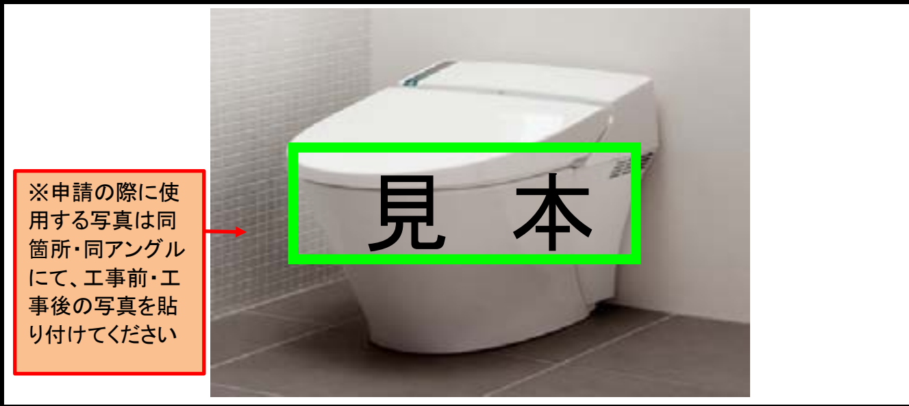
工事後の写真(撮影日:平成〇〇年〇〇月〇〇日、撮影者:建築 幸造)
