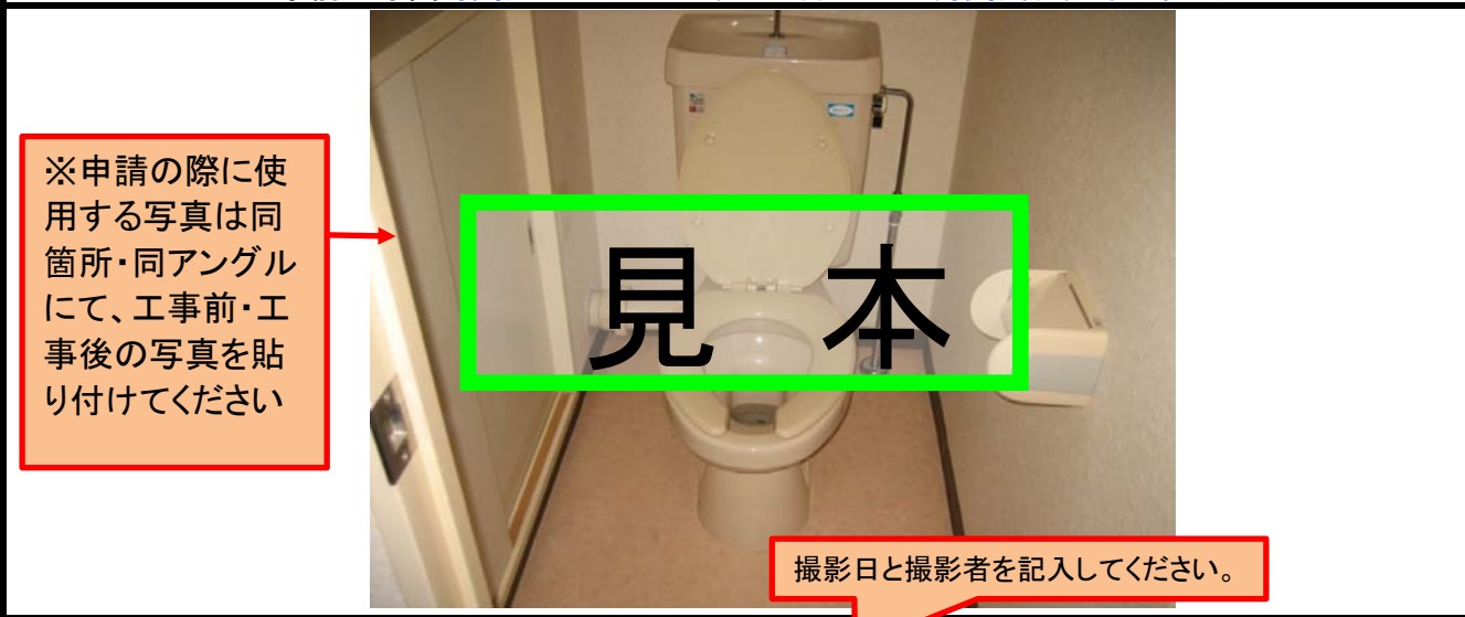
工事前の写真(撮影日:平成〇〇年〇〇月〇〇日、撮影者:建築 幸造)
